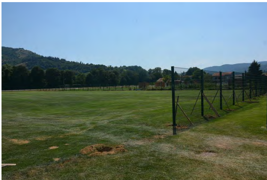
Clôture du Stade de foot (5 989,78 HT) réalisée pour permettre son accès au public
