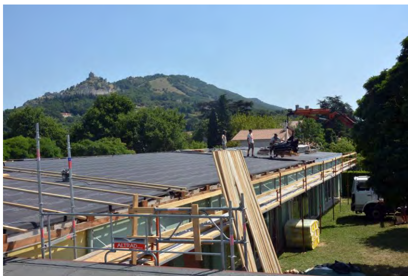
Réfection de la toiture de l'école maternelle des Brémondrières (89 548,53 HT)
