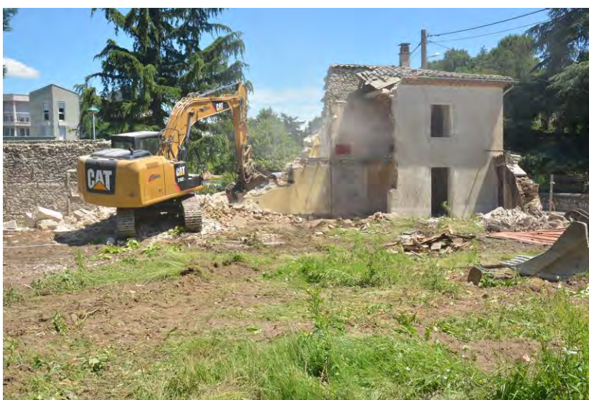
Démolition de l'ex maison CROUZET, chemin de Hongrie (21 800 HT) et aménagement d'une plateforme provisoire
