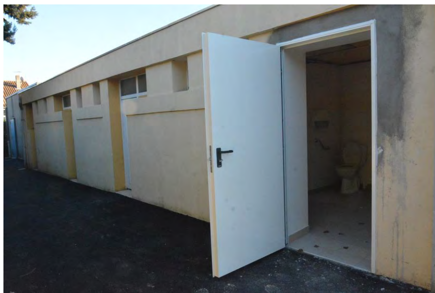
Travaux au stade bouliste dans le cadre de l'Ad'AP (13 613,32 HT)
